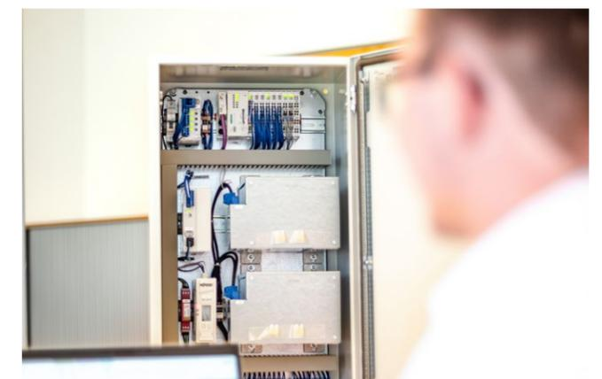
▲ Paramentrierung einer Fernwirkanlage ▲
